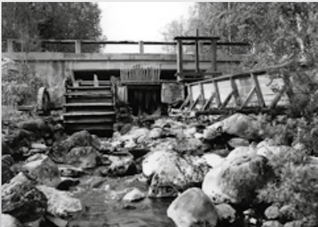
Miettulan saha, vesirattaan jäännökset
